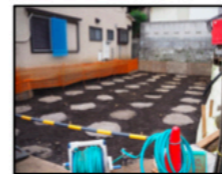
基礎工事 2020年10月30日
