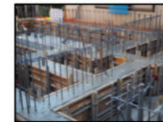
1階躯体工事 2020年11月13日
