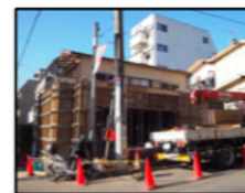
1階躯体終了 2020年12月4日
