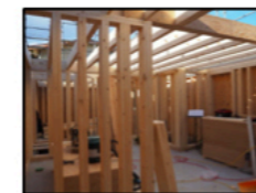
2~5階躯体工事開始 2020年12月25日
