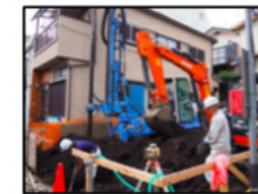
地盤改良工事 2020年10月22日
