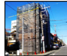
2~5階躯体工事完了
